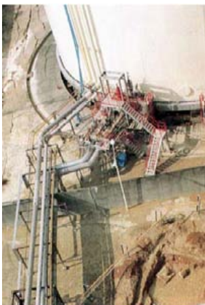
写真-1 兵庫県南部地震のタンク本 弁からのLPG漏洩箇所の状 況 2)
